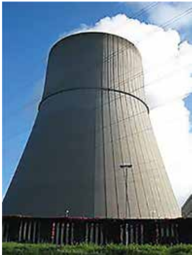
Kühlturm AKW Emsland, Quelle: Wikipedia
